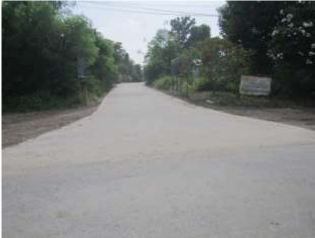
๑๐. โครงการก่อสร้างถนนคสล.สายหมู่ใหญ่ หมู่ที่ ๑
